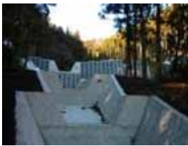
本川堰堤(H21完成)
