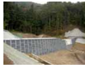
支川堰堤(H21完成)
