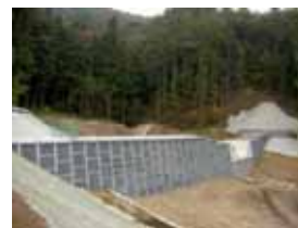
支川堰堤(H21完成)
