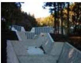
本川堰堤(H21完成)
