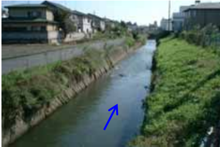
未改修区間(用地買収済み)
