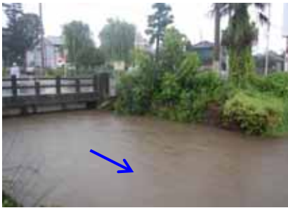
橋桁に達する出水
