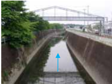
現況河川 狭小部
