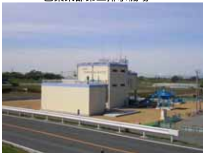
邑楽東部第二排水機場
