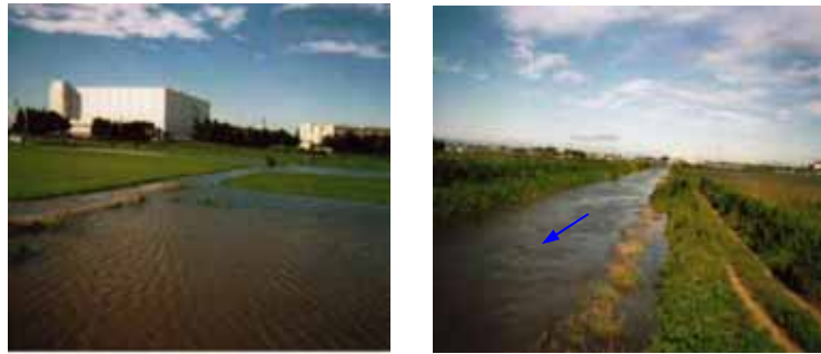
平成14年7月9日(台風6号による被害状況)
