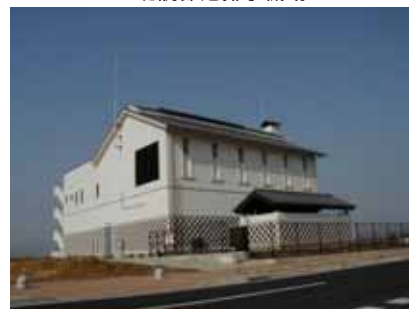
北調節池排水機場
