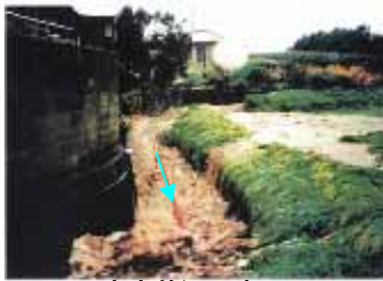
出水状況写真
