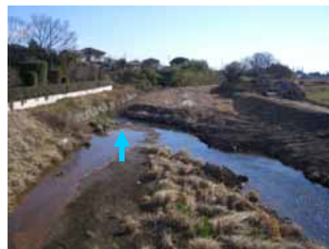
暫定改修区間
