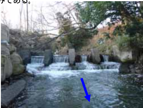
改修予定の取水堰(平成21年12月)
