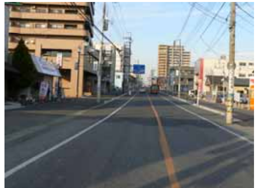
拡幅完了箇所の状況
