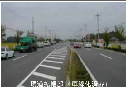
現道拡幅部(4車線化済み)
