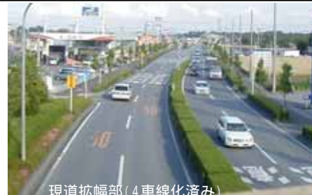
現道拡幅部(4車線化済み)
