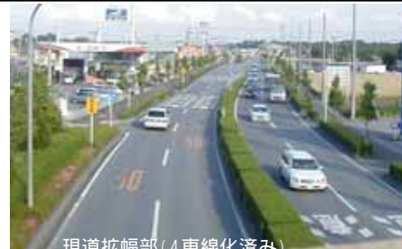
現道拡幅部(4車線化済み)
