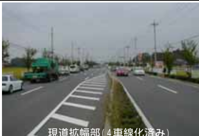
現道拡幅部(4車線化済み)
