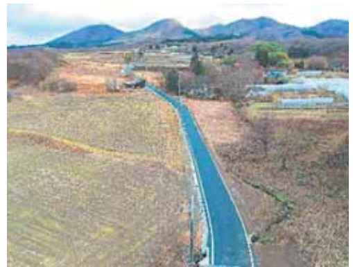
保全対策が行われた農道 (東吾妻町：榛名西麓1期地区)
