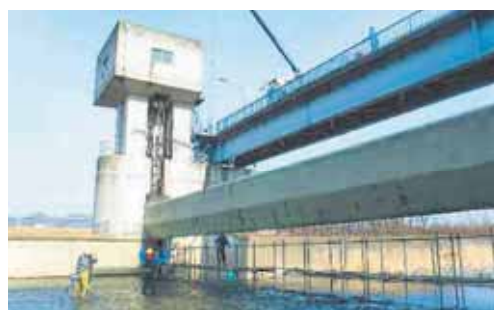
太田頭首工洪水吐ゲートの補修整備 （桐生市：渡良瀬川中央地区）
