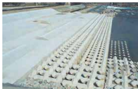
改修後の坂東大堰本体
