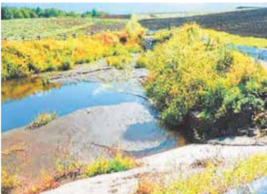
沈砂池の堆積状況（孺恋村）
