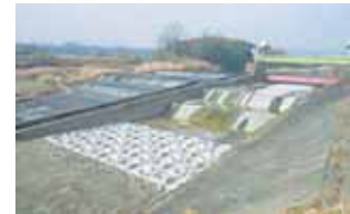
事業実施後の長野堰頭首工
