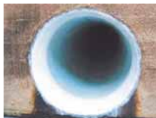
基幹農業水利の管更正工による長寿命化対策 （みどり市：大間々用水地区）
