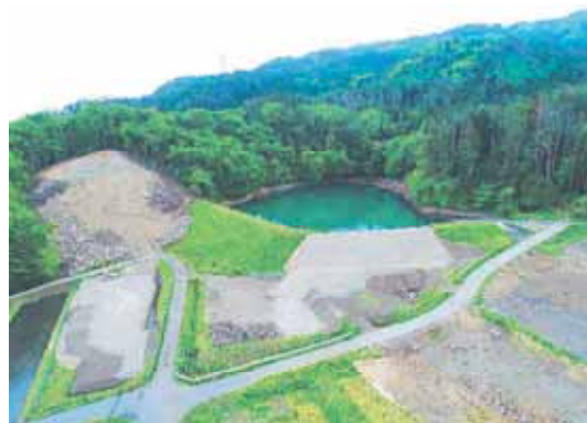
(みなかみ町池田地区「豪雨及び耐震化対策」(工事実施中))
