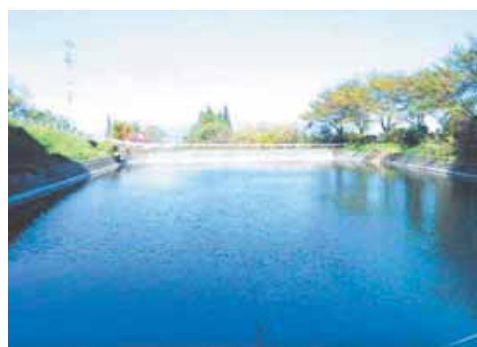
県単事業により改修した中野貯水池
