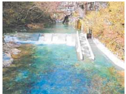
長寿命化が図られた頭首工 (中之条町：美野原地区)
