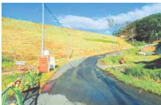
耐震化工事の施工中写真(大谷池)
