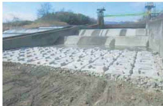
長寿命化施工中写真(長野堰頭首工)
