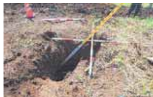
突発的に陥没した農地
