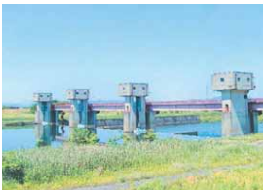
邑楽頭首工 (館林市：渡良瀬川沿岸地区)
