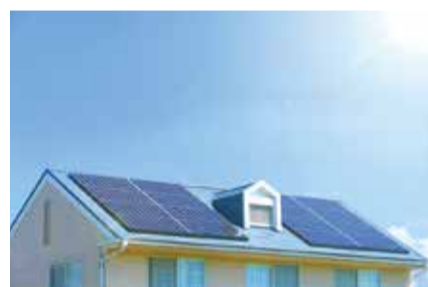
台風や雷による破損も報告が必要です
