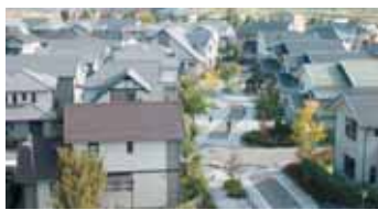
防災・景観に配慮した無電柱化地区
