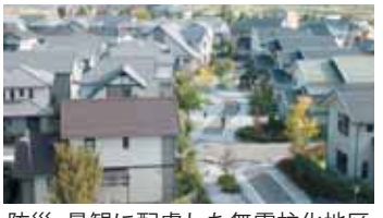
防災・景観に配慮した無電柱化地区
