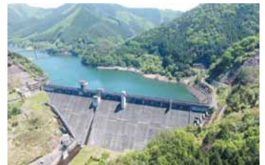
上空から見た桐生川ダム
