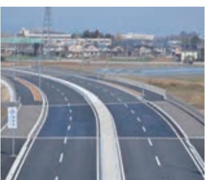
3月26日に開通した国道122号館林明和バイパス
