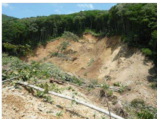
山地災害の発生状況（着工前）
