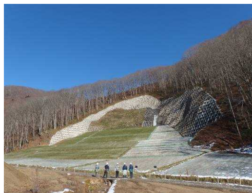
山地災害の復旧状況（山腹工完成）
