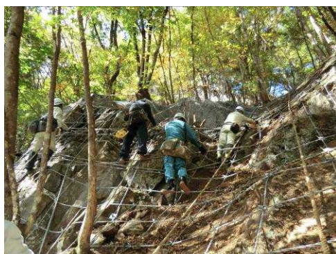
危険地区の事前防災（落石防止対策）
