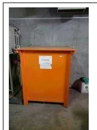
リハビリ棟 PCB 置場
