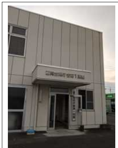
藤岡合同庁舎 別館
