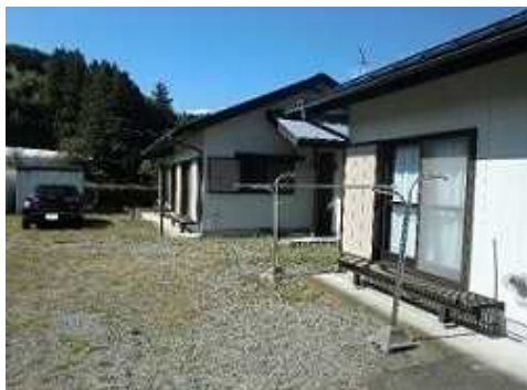
ハッ場ダム水源地域対策公舎①
