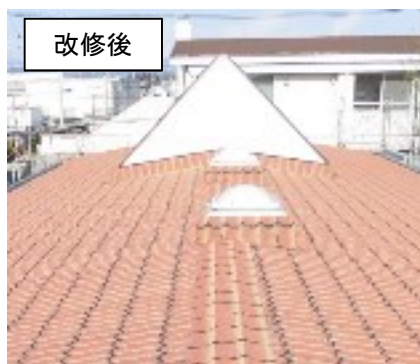
中央児童相談所一時保護所棟防水改修工事
