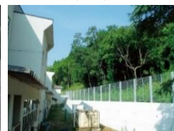
がけ崩れ対策
