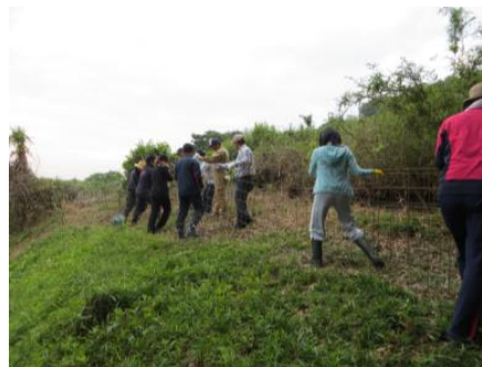
住民主体の侵入防止柵の設置
