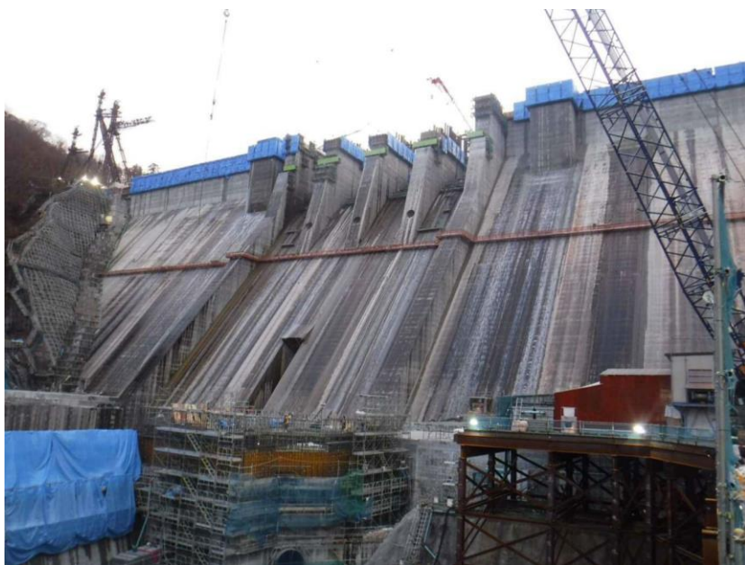
ハツ場ダム本体工事
