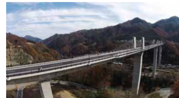
ハッ場大橋(H26完成)
