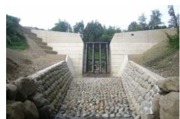
砂防堰堤の整備例:戸倉沢(みなかみ町)
