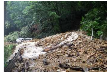
国道291号(みなかみ町)の土砂流出状況(H27年9月)
