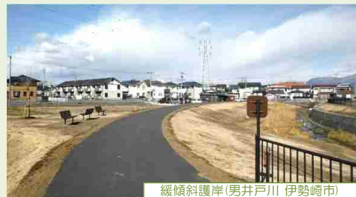
緩傾斜護岸(男井戸川 伊勢崎市)
