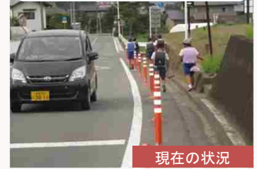
県道高崎神流秩父線 吉井町神保工区
