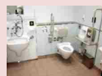
高齢者・障害者対応トイレ
