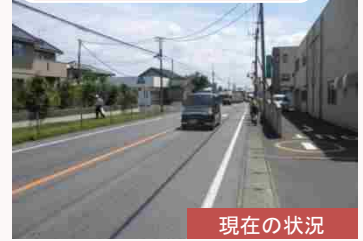
県道足利伊勢崎線 天良工区
