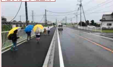
通学路の歩道整備
