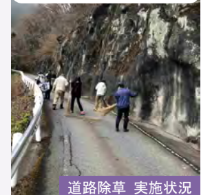
道路除草 実施状況
