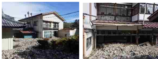
着手前（被災した新鹿沢温泉）
