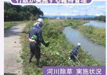
河川除草 実施状況
