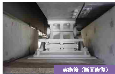
実施後（断面修復）
