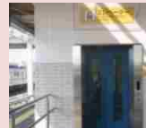
エレベーター設置
