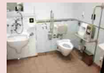
高齢者・障害者対応トイレ
