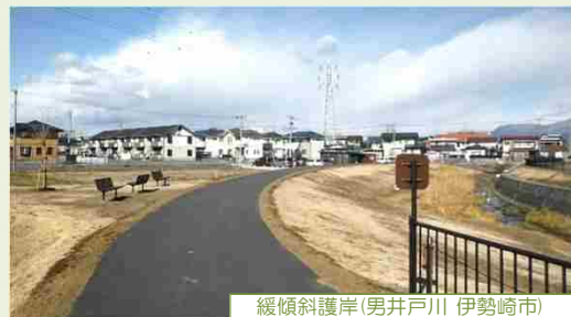
緩傾斜護岸(男井戸川 伊勢崎市)
