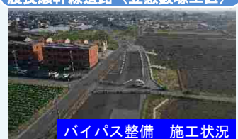
渡良瀬幹線道路（笠懸藪塚工区）
