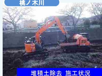
堆積土除去 施工状況
