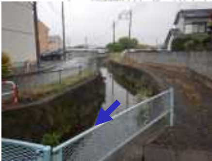
② 未整備区間
