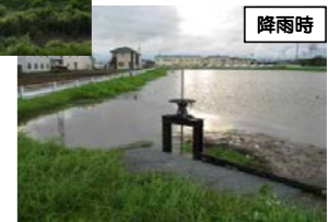
整備済調節池の状況
