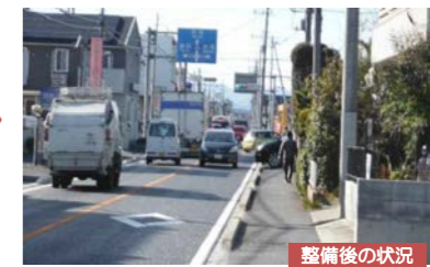
整備後の状況
