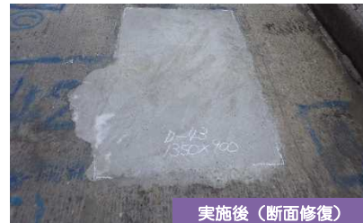
実施後（断面修復）
