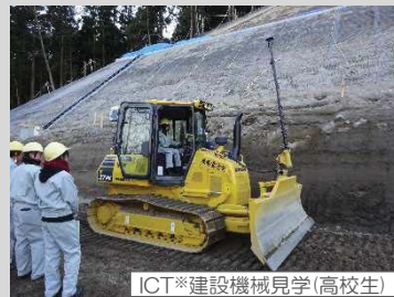
ICT建設機械見学(高校生)
