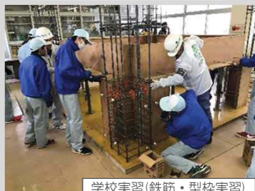
学校実習(鉄筋・型枠実習)
