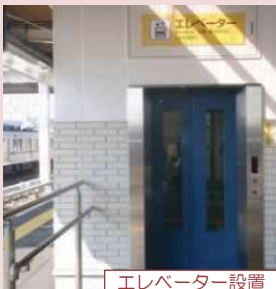
エレベーター設置
