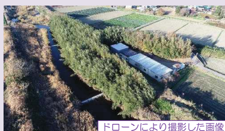
ドローンにより撮影した画像
