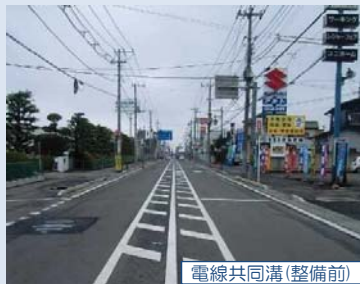
電線共同溝(整備前)
