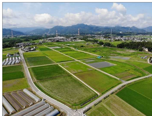
農地の状況(整備後)
