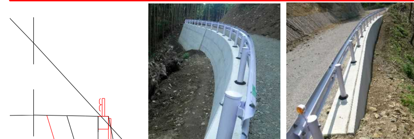
<現場打ちコンクリート擁壁>
