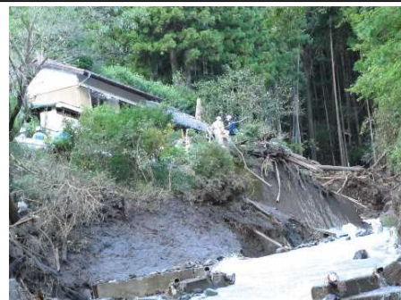
(令和元年度台風第19号による豪雨により発生した土石流)
