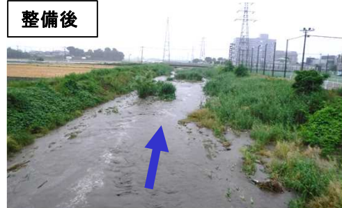
整備後 出水状況(山崎橋下流)
