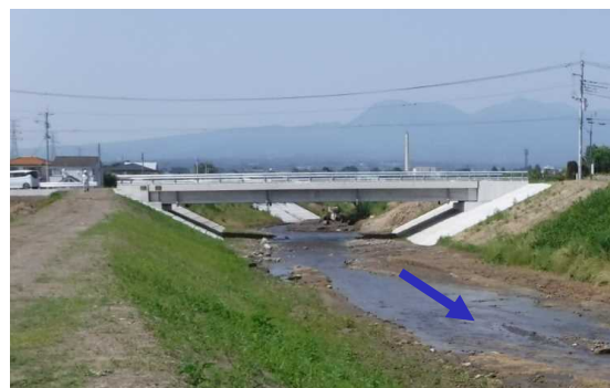
② 橋梁整備状況(堀の下新橋)
