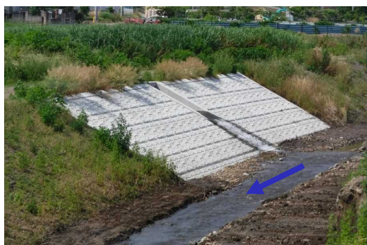
③ 樋管整備状況
