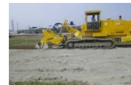
地盤改良工の追加
