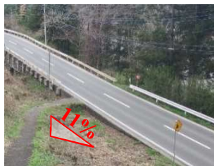
現道の状況(急勾配)
