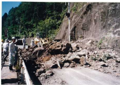
(国)353号崩落の状況(H14)
