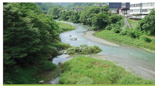
瀬や淵を保全した河川整備（神流川 神流町）
