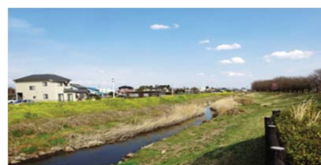
緩傾斜護岸（石田川 太田市）
