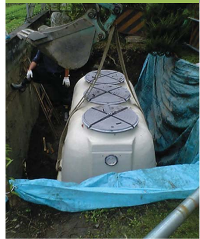
藤岡市浄化槽 施工状況
