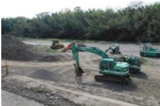
建設発生土ストックヤードの整備による 残土の有効活用の促進
