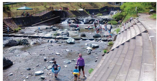
階段工（三波川 藤岡市）
