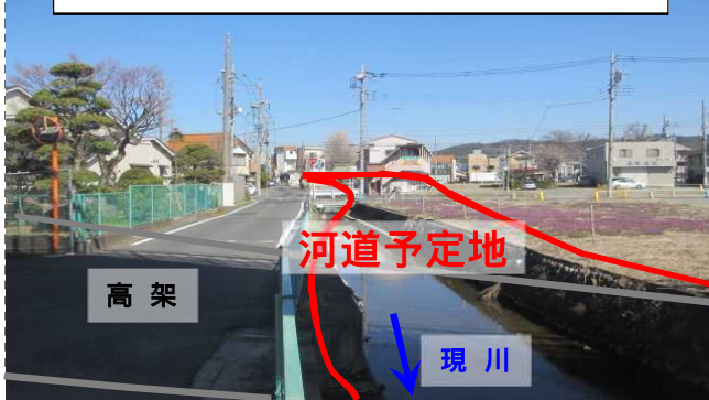
上流工区の河道用地
