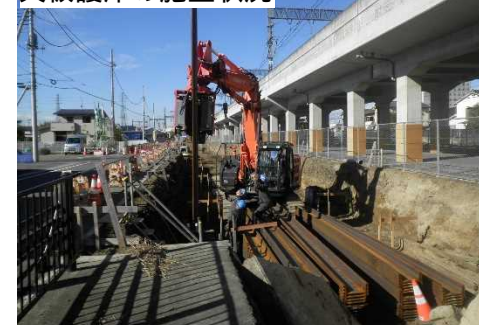
矢板護岸の施工状況
