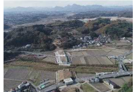
工事が進む安中工区
