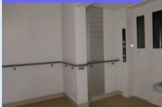
エレベーター、廊下の手すり
