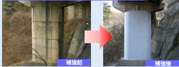
橋梁耐震化の例 (国道254号11号橋：下仁田町)
