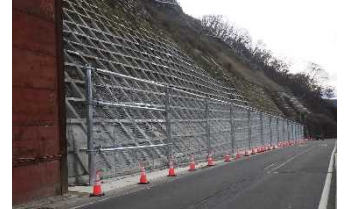
国道120号 菅沼工区 施工状況
