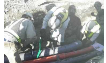
県道藤岡本庄線 藤岡工区 施工状況
