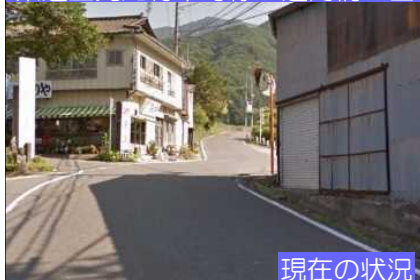
県道上発知材木町線 透門橋工区
