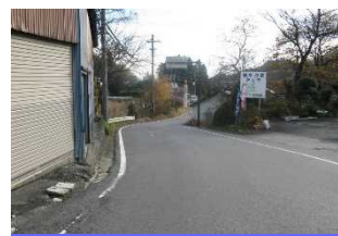
道路幅狭小・線形不良
