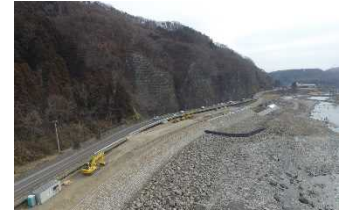
国道353号 村上工区 施工状況
