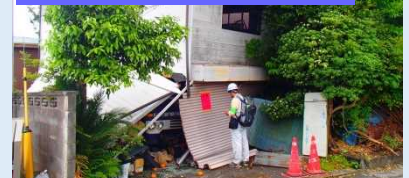
派遣先での活動状況 (熊本地震)
