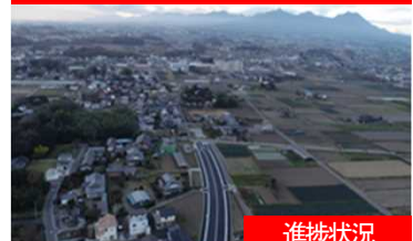
県道南新井前橋線バイパス2期工区
