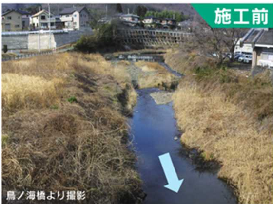
①改修前(鳥ノ海橋から上流を望む)
