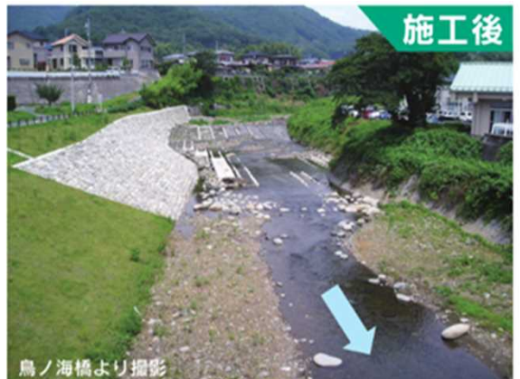
①改修後(鳥ノ海橋から上流を望む)
