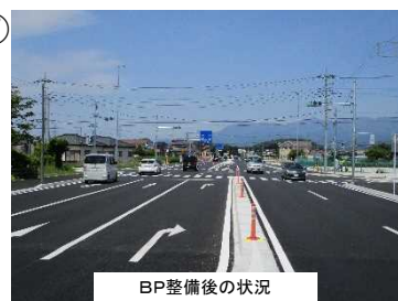
BP整備後の状況
