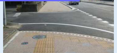
歩道の段差解消・視覚障害者誘導用ブロック設置
