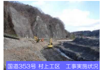
国道353号 村上工区 工事実施状況
