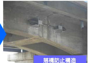
落橋防止構造
