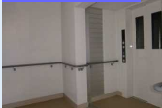
エレベーター、廊下の手すり
