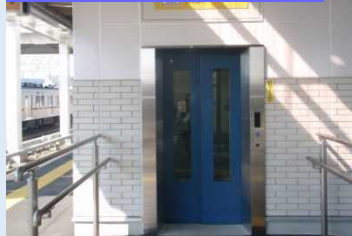
段差解消（エレベーター設置）
