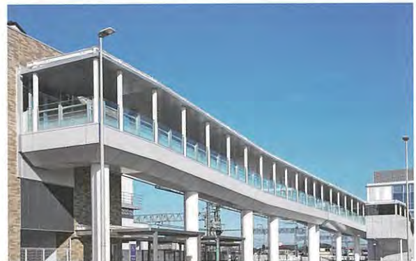
駅舎と接続するペDESTリアンデッキ
